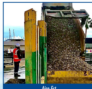
Aire Est mise en oeuvre du ballast
