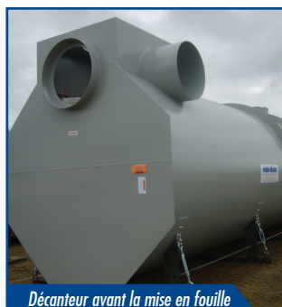
Décanteur avant la mise en fouille
