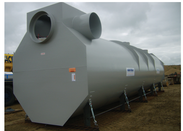
Décanteur en attente de mise en fouille
